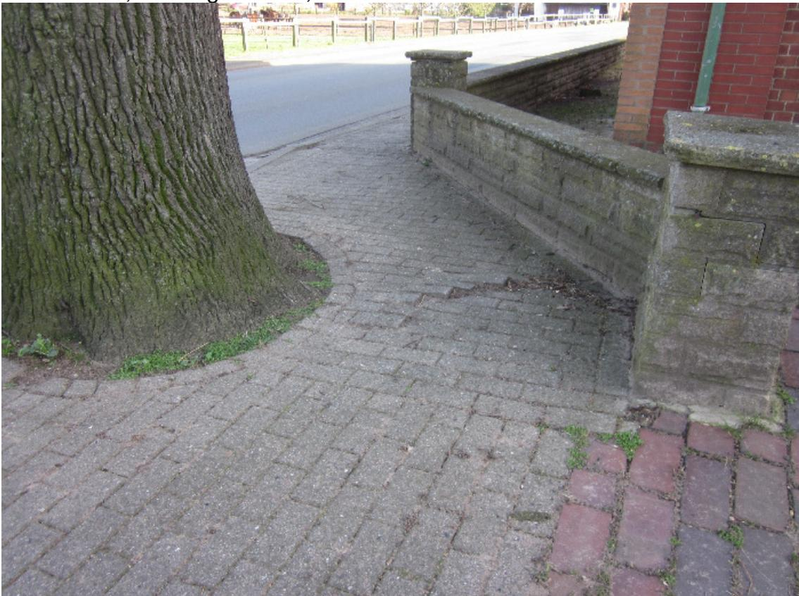
Foto 12: Gehwegschäden
